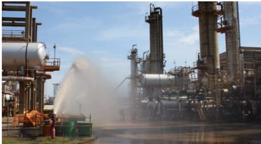
Figura 10 - Cortina de água para conter vazamento de GLP não tratado (Fonte: Arquivo interno da empresa)
